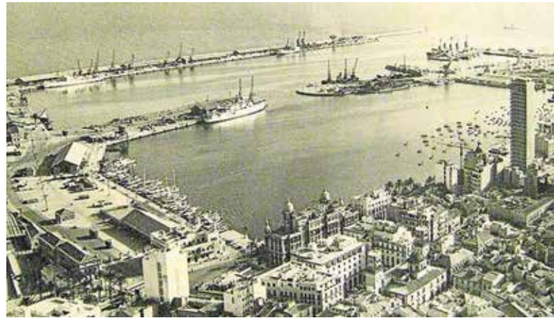
Vista general del puerto de Alicante.
