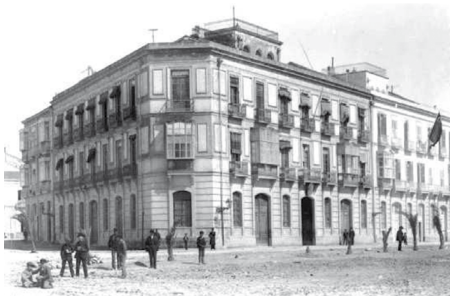
Edificio que fue, entre otros, Dependencia de Hacienda del Estado, Escuela de Comercio; y, actualmente, Sede Universitaria Ciudad de Alicante de la UA.
